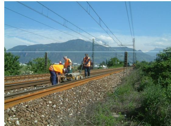
Binario interessato ai Lavori
