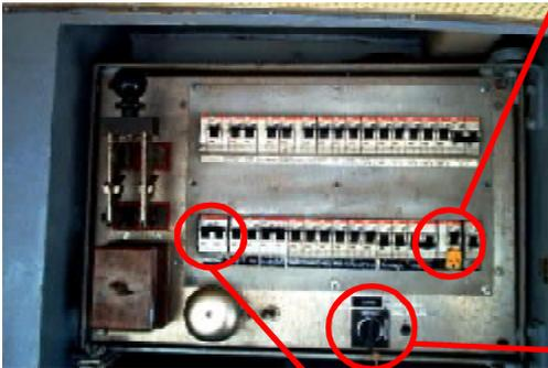
In cabina A, nel quadro BT, è postol'interruttore IARC di alimentazione del Cab-Radio
