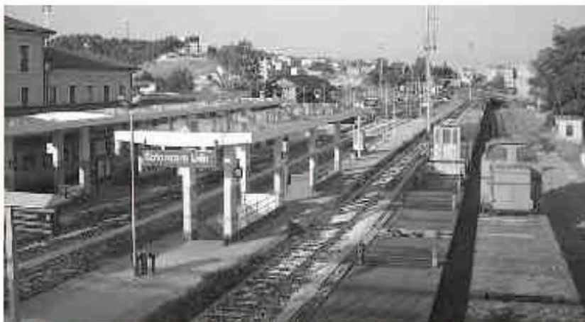
ISOLATI La stazione di Catanzaro Lido; sopra il ponte crollato di Marcellinara
